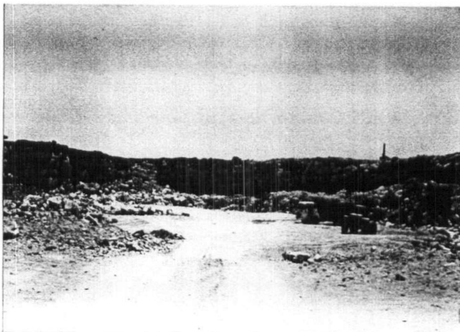
Est. 510.— Explotación de calizas cretácicas para áridos de trituración, en Guadalix de la Sierra.
